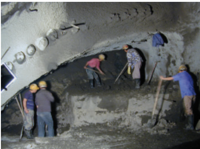
Bild 12. Vortrieb mit Handarbeit in Temporärschacht 3 Fig. 12. Mining by manpower in temporary shaft 3
