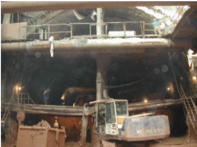
Bild 11. CRD Vortrieb vom Temporärschacht nach Norden Fig. 11. CRD -mining from temporary shaft in northern direction
