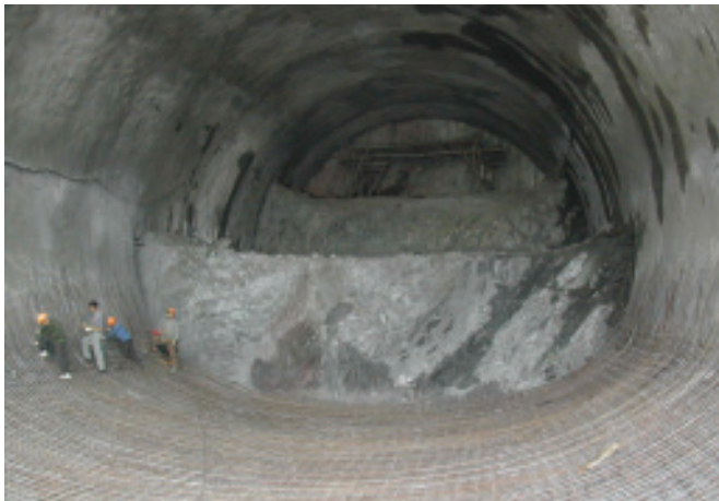
Bild 14. Strossen – Kalotten – Vortrieb in Devonquarziten mit Sohlbewehrung am Nordportal
