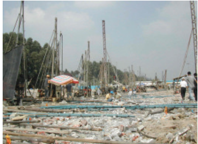
Bild 9. Hochdruckinjektionen am Vertikalschacht 1 Fig. 9. High-pressure injections near vertical shaft 1
